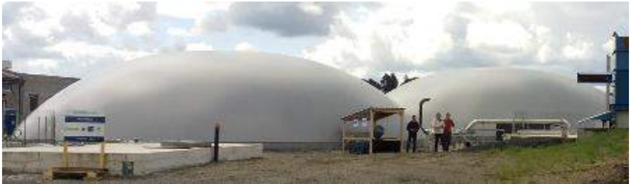
Exemple : fosses de digestion enterrées
