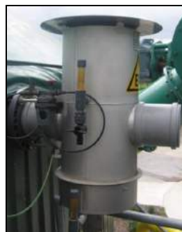
Soupape de sécurité surpression/dépression
