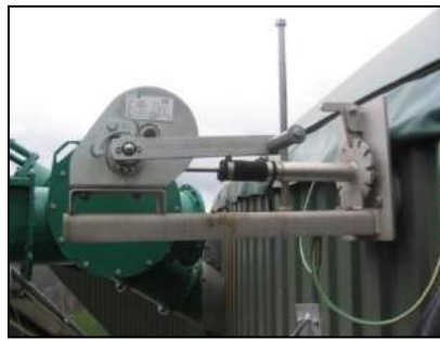
Agitateur immergé avec système d'orientation extérieur
